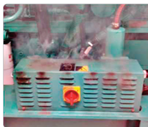
사례 3 : 진동으로 인한 볼트 풀림으로 쇼트, 먼지 방치로 인한 화재 발생
