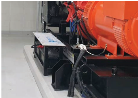
〈그림 3-23〉 발전기세트에 장착된 배터리
